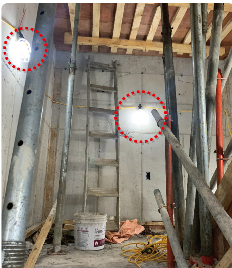
〈개선 전〉 가설 전구 설치
