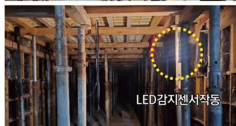
〈개선 후〉 무선 LED 조명 설치
