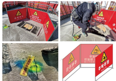
〈개선 후〉 바닥 개구부 3중 안전조치
