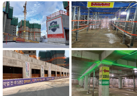
〈개선 후〉 청결하고 정돈된 건설현장
