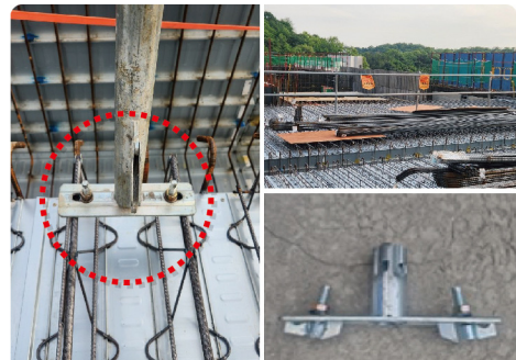
〈개선 후〉 철근 전용 안전난간 설치
